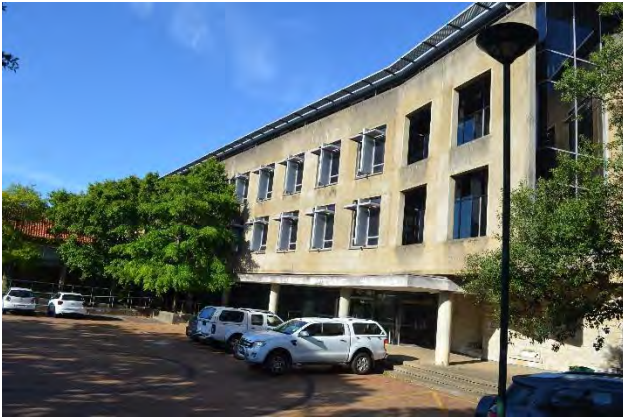
Abbildung 2: Gebäude des Departments of Chemical Engineering.
