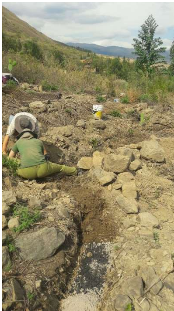
Anlegen und Bepflanzen der Terrassen
